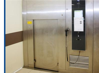
Anschließend werden die verpackten Siebe in einem speziellen Dampfsterilisationsgerät keimfrei gemacht. Dazu müssen exakt definierte Temperaturverläufe und wechselnde Drücke eingehalten werden. Nur wenn diese Bedingungen genau erfüllt waren, wird das Sterilgut nach einer erneuten Prüfung zur Verwendung freigegeben.
